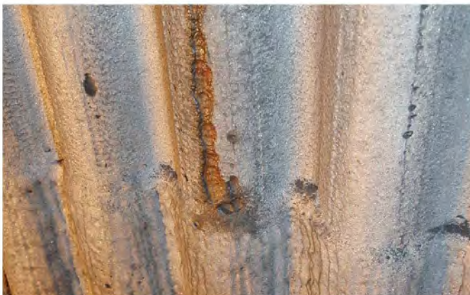
Bild 6: Im gereinigten Zustand können die Werkstoffoberflächen mit streifendem Licht abgeleuchtet und die Messungen der Restdicken an den am stärksten angegriffenen Orten gemessen werden. Somit kann die Restnutzungsdauer der Werkstoffe bestimmt werden.
