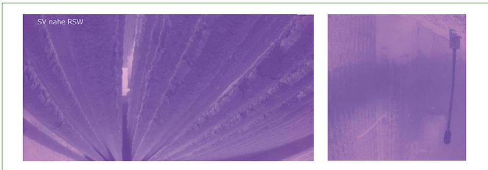
Bild 8: Standbilder aus Videoaufnahmen der Begleitung eines Shower Cleaning Systems; a) Blick in die Rohrgassen des Schutzverdampfers; b) Reinigungsvorgang und Reinigungseffekt
