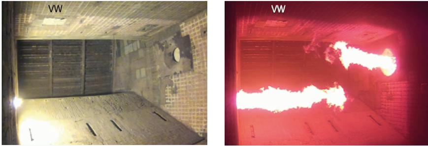
Bild 9: Standbilder aus Videoaufnahmen der Anfahrbegleitung und Beobachtung des Verhaltens neuer Feuerfestzustellung; a) neu angebrachte Feuerfestzustellung und Brennerstart; b) Brennerbetrieb
